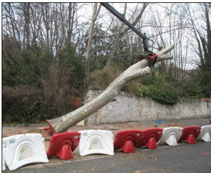
Exemple de dépose délicate d'un tronc creux au grappin hydraulique
